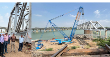
पश्चिम रेलवे के वडोरा मंडल द्वारा अहमदाबाद-वडोरा रेलखंड पर महिसागर नदी के ऊपर स्थित ब्रिज संख्या 624 के सभी 8 स्पैनों के री-गर्डरिंग कार्य को सफलतापूर्वक पूर्ण किया गया। यह भारतीय रेल के लिए एक ऐतिहासिक उपलब्धि है, जहाँ रनिंग रेल लाइन पर 67.5 मीटर स्पैन तथा लगभग 320 टन वजन की स्टील ओपन वेब गर्डर का 600 टन एवं 800 टन क्षमता की रोड क्रॉलर क्रेनों की सहायता से प्रतिस्थापन भारतीय रेल में पहली बार किया गया है। इस ऐतिहासिक उपलब्धि पर वडोरा मंडल के मंडल रेल प्रबंधक श्री राजू भडके ने बताया कि महिसागर नदी पर स्थित इस 113 वर्ष पुराने महत्वपूर्ण रेलवे पुल के सभी 8 स्पैनों का सफल री-गर्डरिंग कार्य वडोरा मंडल की इंजीनियरिंग दक्षता, नवाचार और टीम भावना का उत्कृष्ट उदाहरण है। उन्होंने बताया कि यह कार्य अत्यंत चुनौतीपूर्ण परिस्थितियों में, निर्धारित समयसीमा के भीतर तथा न्यूनतम बजट में पूरा किया गया है। इसके लिए उन्होंने इस कार्य से जुड़े ब्रिज, टीआरडी, पी-ने, ऑपरेंटिंग, इलेक्ट्रिकल एवं मैकेनिकल विभागों
