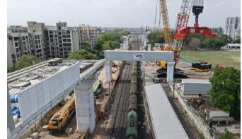
तकनीक के तहत साइट पर ही तैयार किया गया और एकीकृत भारी इकाई के रूप में स्थापित किया गया। मणिनगर रेलवे स्टेशन के पास ऐसे कुल पांच बीम लगाए जाने की योजना है, जो इस पूरे सेक्शन में बुलेट ट्रेन कॉरिडोर के लिए मजबूत संरचनात्मक आधार प्रदान करेंगे। इस जटिल इंजीनियरिंग कार्य की सबसे खास बात इसकी समय-सीमा रही। जहां
