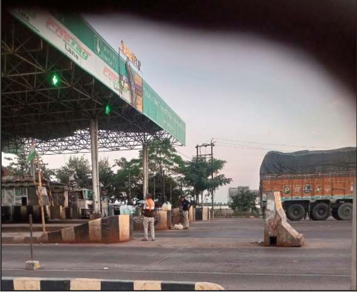
टोल प्लाजा पर हर दिन टोल वसूला जा रहा है । लेकिन यहां पर अभीतक
